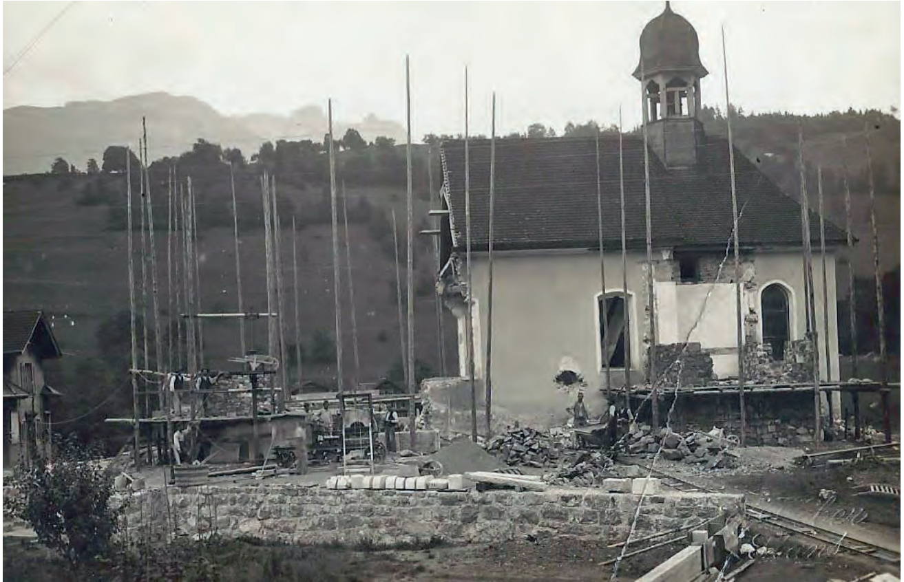
Die Fotografie vom Juli 1925 zeigt die Kapelle beim Umbau. Über dem Bauarbeiter ist das Loch zu erkennen, das beim Sprengstoffanschlag in die Mauer gerissen wurde. Quelle: Paul Matter, Ennetmoos
